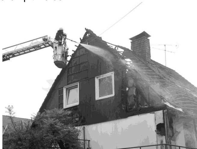
Dachstuhlbrand Steilweg am 22.07.2001
